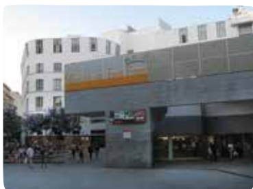
Equipamiento polifuncional Fort Pienc, Barcelona, 2006.
